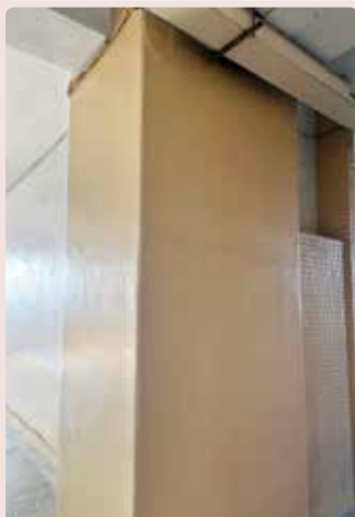
走廊扶輪意象牆變身前
